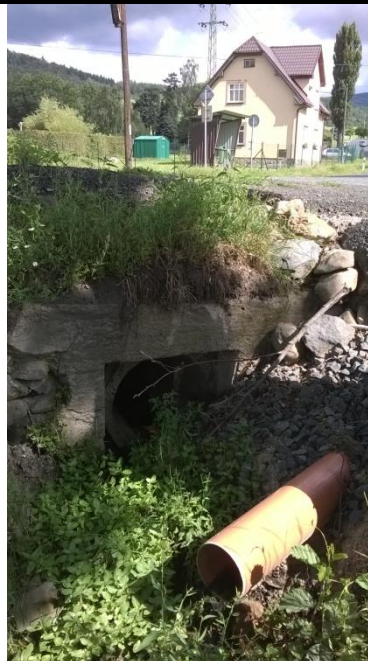
vyústění DN 400 (bezejmenného přítoku Vitického potoka
