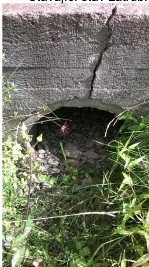
Stávající stav zatrubnění bezejmenného přítoku
